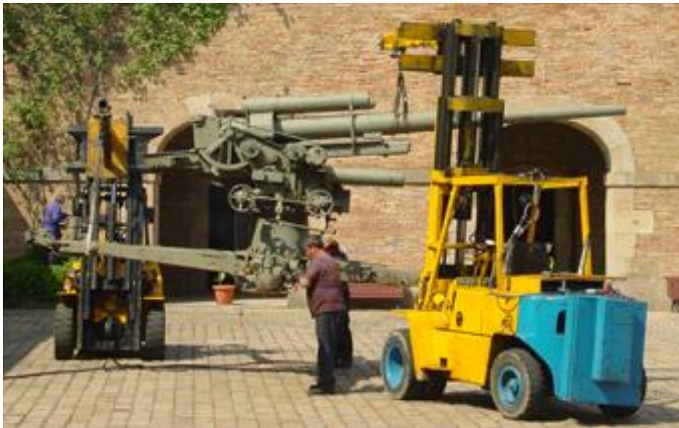
Cañón A.A. de 88/56, "Flak 18". Le fueron seccionados en parte los soportes, para hacerlo pasara por la puerta
